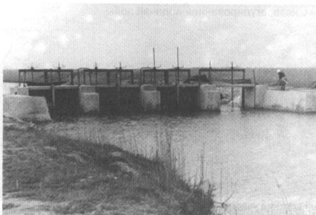
Рис. 6. Сбросной шлюз на Зозулиевском гирле (Жестерская группа) по учету производителей судака и тарани и их молоди, скатывающейся в море
